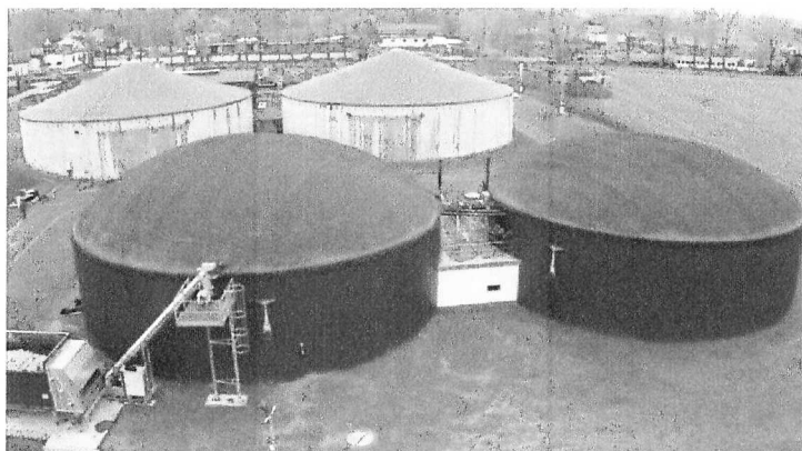
Zbiornik biogazu Biolene® zainstalowany na zbiornikach fermentacyjnych Źródło: www.agrikomp.pl
