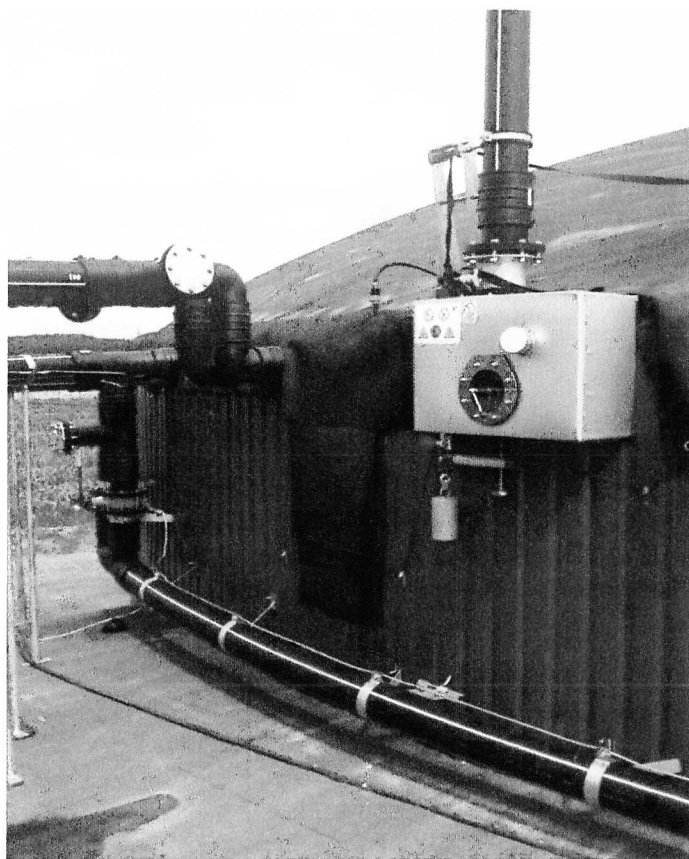
Widok bezpiecznika biogazowego Bioguard II® oraz fragmentu orurowania gazowego zbiornika gazu Biolene® Źródło: www.agrikomp.pl
